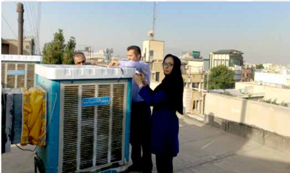
نصب عایق یونولیتی در کولرهای آبی
