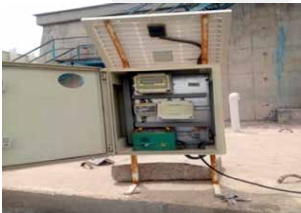
تصویر شماره (۲): نمونه‌ای از نصب تجهیزات ابزار دقیق
