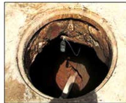
تصویر شماره (۹): دستگاه نشت یاب آنلاین آب ORTOMAT-MT
