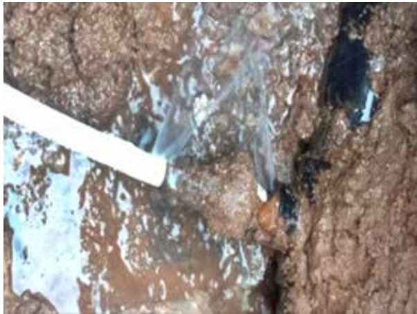
تصویر شماره (۸): نمونه‌ای از کشف نشت در شبکه و انشعابات آب
